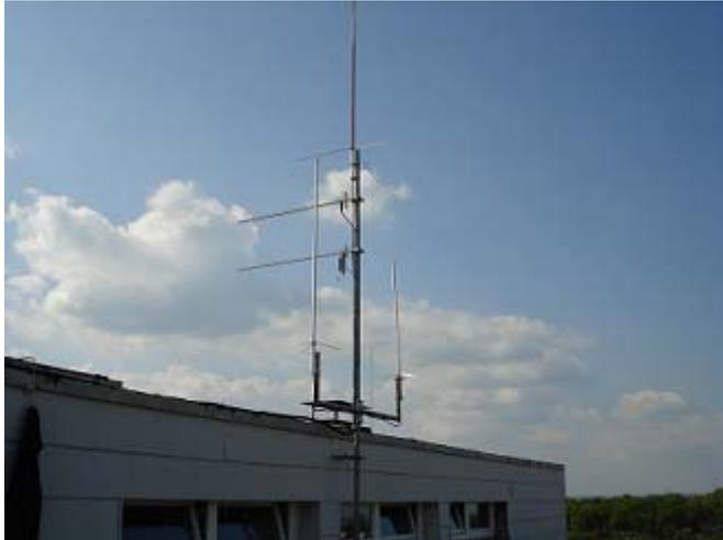
Nun wurde eine neue Rundstrahlantenne X-6000 über der Schlitzantenne montiert und der komplette Mast wieder aufgestellt. Die folgenden ATV Empfangsversuche auf 13cm waren leider nicht erfolgreich, so das wir noch eine 13cm Yagi als Empfangsantenne für die User Richtung Westen mit einem Konverter und neuem Kabel am Mast 2 installierten. Mit dieser Antenne hatten wir gute Empfangsergebnisse. Die 13cm Schlitzantenne wird jetzt als zweite Empfangsantenne verwendet.
