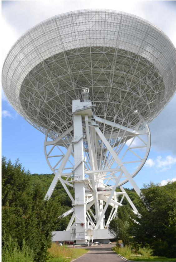
Mit diesem Radio-Teleskop wird Grundlagenforschung im Weltall betrieben, denn anders als Licht werden Radiosignale durch Staubwolken kaum absorbiert.
