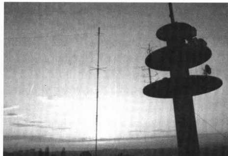
KW-Antenne von DKØII und FMT der Telekom-NL Schwäbisch-Hall.
