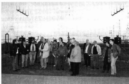
Eine der letzten BV-Mitgliederversammlungen des BV Köln mit Teilnehmern aus den OVs Köln, Z12, und Aachen, Z32, wurde in Jülich im Hause der Rundfunk-Sendeanlage durchgeführt. Günter Hirte, DL2QC, sorgte mit einer ausgezeichneten Führung durch das Gebäude und die Außenanlagen für das Extra-Highlight des Tages.
