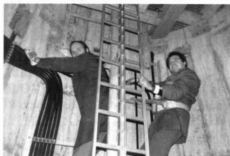
DC9ZB und DJ3GL bei der Kabelmontage für DBØVA im neuen FMT auf der Hohen Wurzel.
