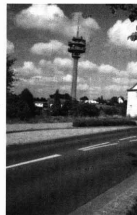
Hier ist DBØWST mit untergebracht.
