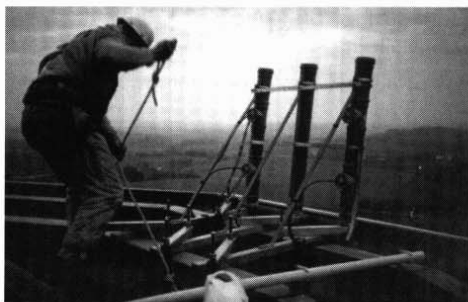
DD3JF 1988 bei der Antennenmontage für DBØACU auf der oberen Plattform des Fernmeldeturms in Mettmann-Metzhausen.
